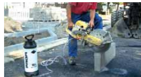
Trennschleifen im Straßenbau
